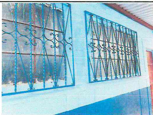
Foto 8: Mantenimiento de balcones
