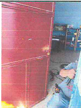
Foto7: Mantenimiento y reparación de puertas (chapas y pintura).
