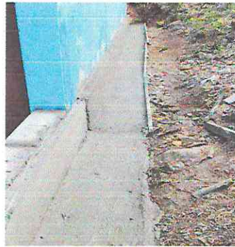
Foto 6: Reparacion de cuneta de concreto en exterior de aula
