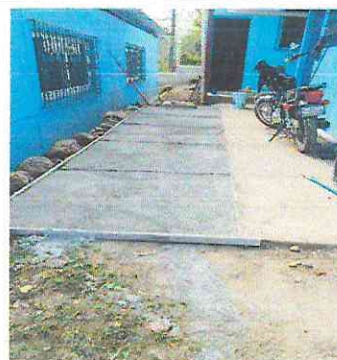
Foto 4: Mantenimiento de losa de patio
