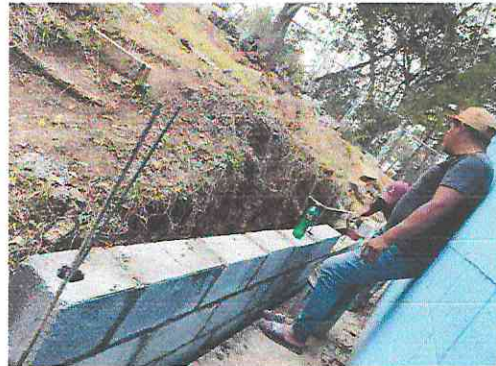
Foto 2: Reparación de Muro de Contención
