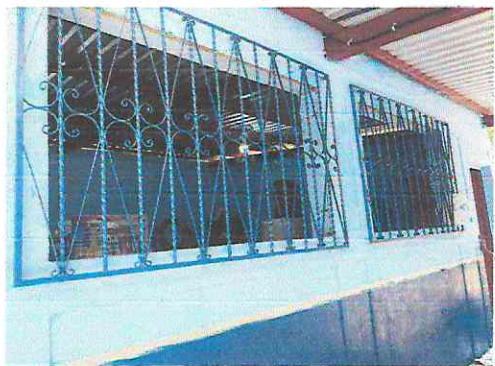
Foto1: Cambio de ventanas y mantenimineto de Balcones
